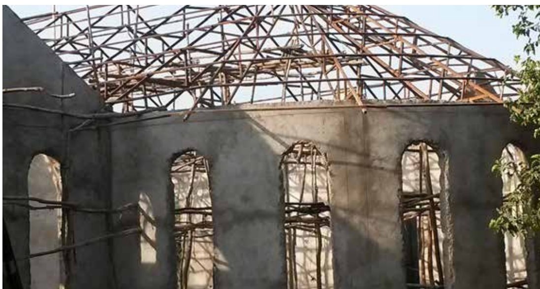
Il tetto della chiesa di Tarcha in costruzione a novembre 2017 - Foto di Renzo Mancini
